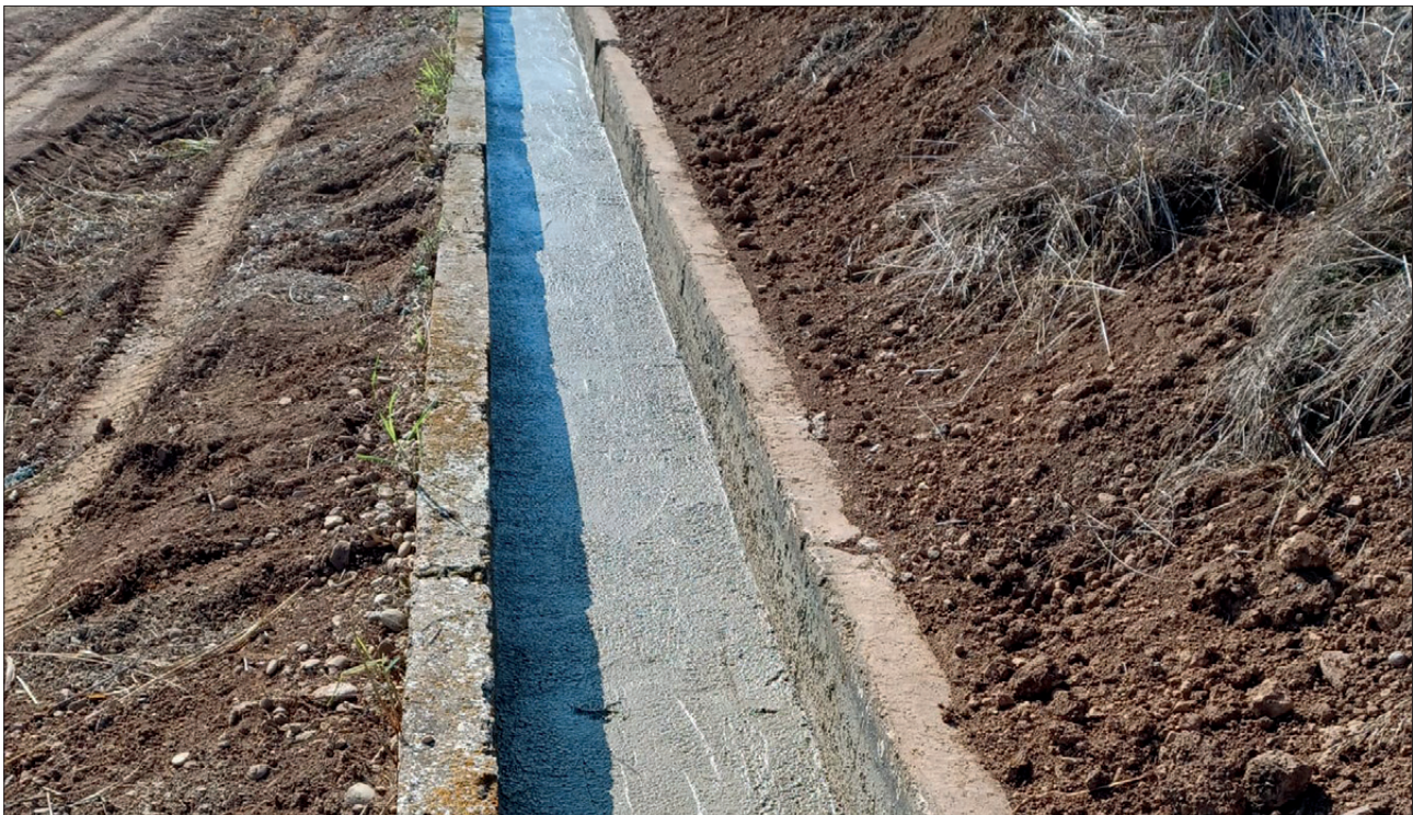
Reparación de la solera de la Acequia A-XIX-3-8.
