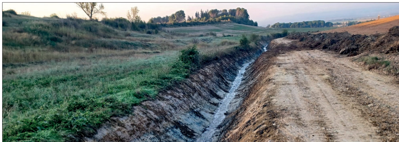
Limpieza desagüe D-XXV-5 en la Zona de El Bayo.
